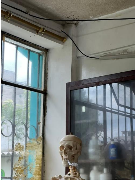
Anexo 22: cables de luz expuestos.
