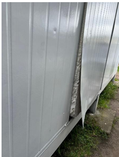
Anexo 15: estructura informal para ampliación de Bar escolar.
