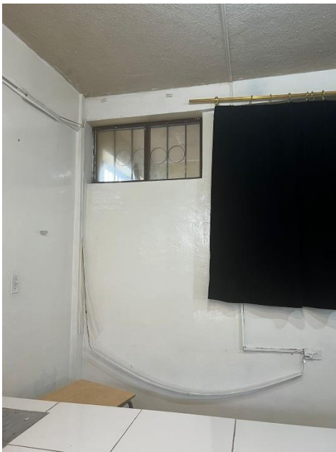
Anexo 22: cables de luz expuestos.
