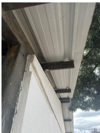
Anexo 9: juntas entre edificaciones.
