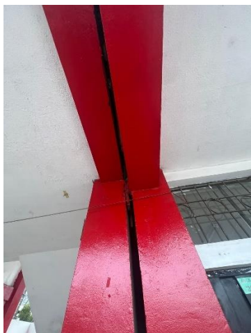
Anexo 10: junta entre edificaciones.
