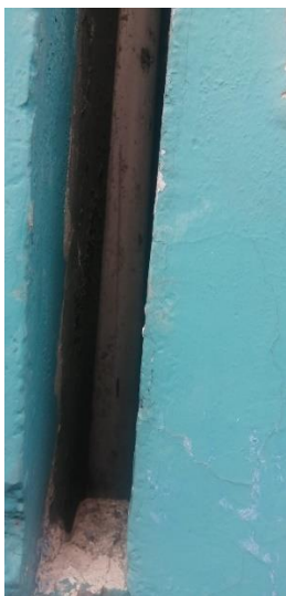
Anexo 11: tubería de agua sanitaria entre las juntas.
