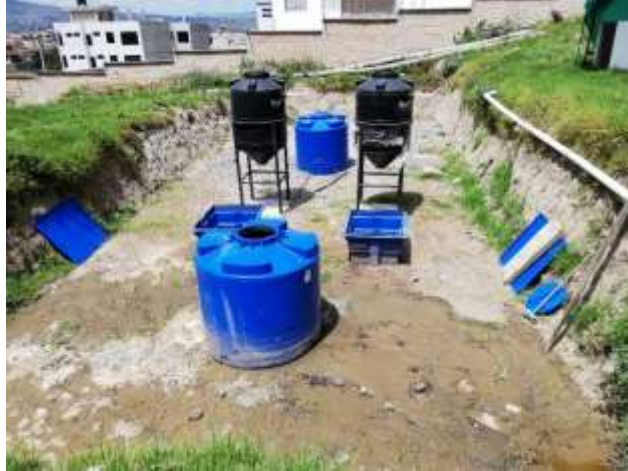
Colocación de tanques
