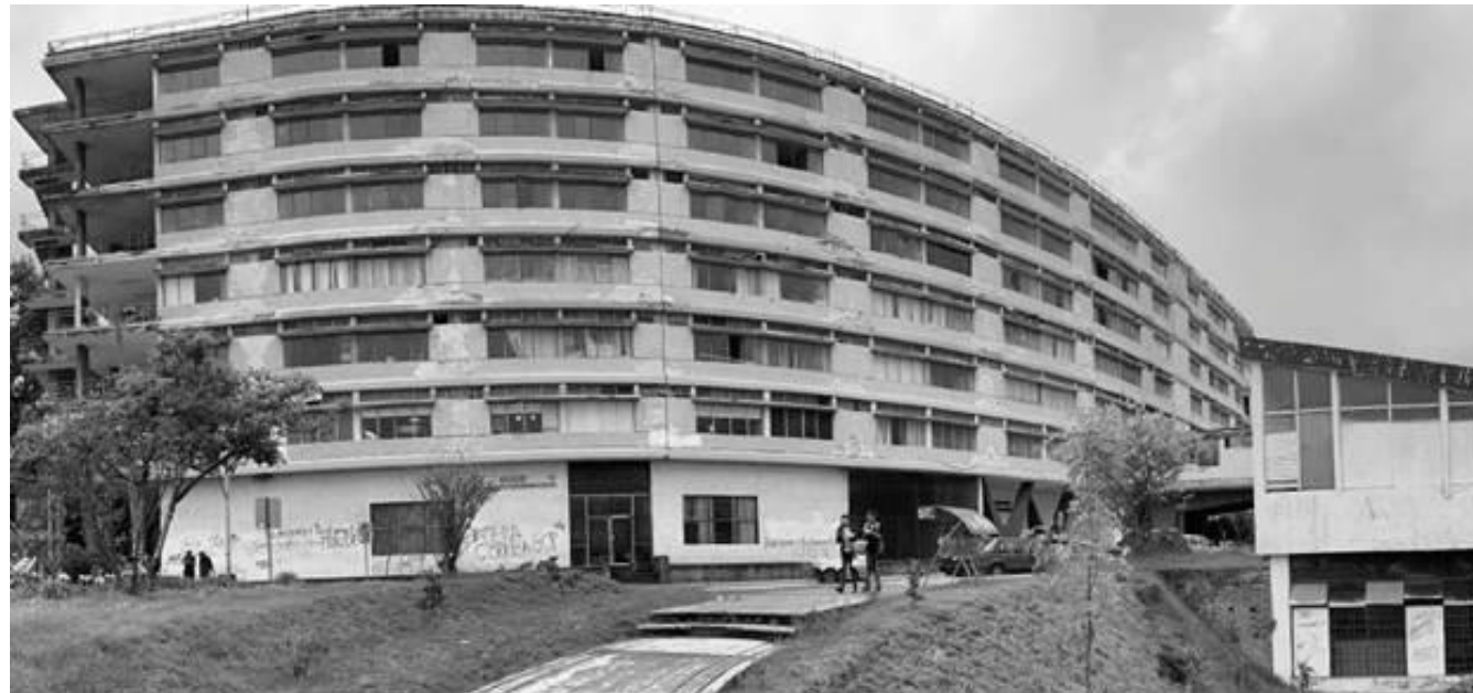
Figura 29 Fotografía panorámica de la residencia universitaria UCE
