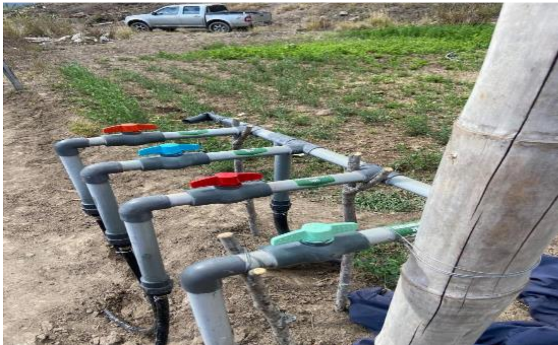
Figura 15 Regulación de válvulas del sistema de riego para cada tratamiento
