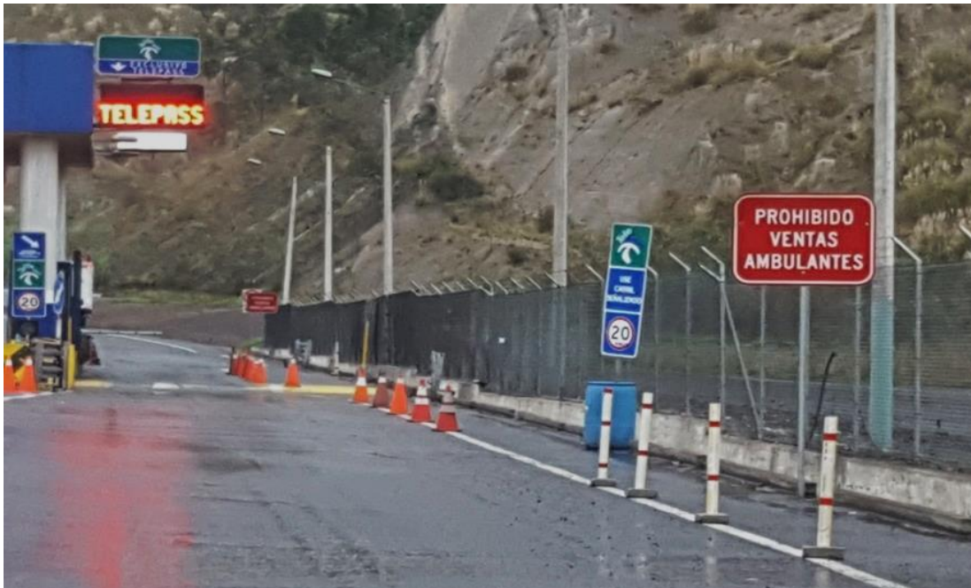
Ilustración 3.9: Señalización horizontal y vertical Elaboración: Álvarez V. Rubén Darío
