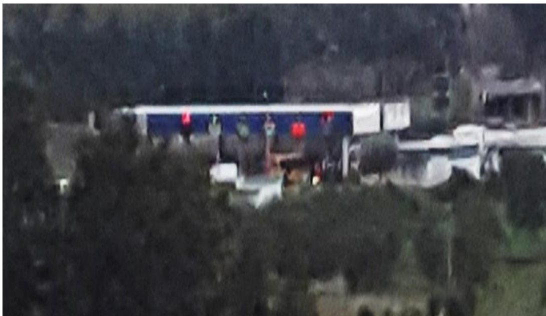
Ilustración 3.2: Cubierta de estación de peaje Elaboración: Álvarez V. Rubén Darío
