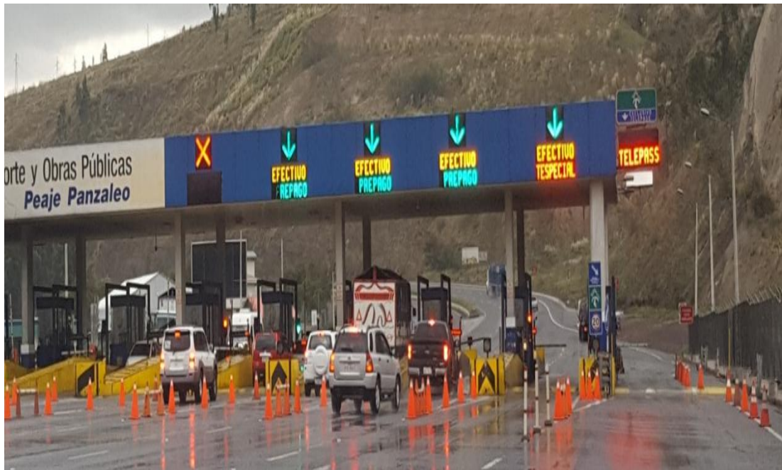
Ilustración 3.3: Accesos a la estación de peaje Elaboración: Álvarez V. Rubén Darío
