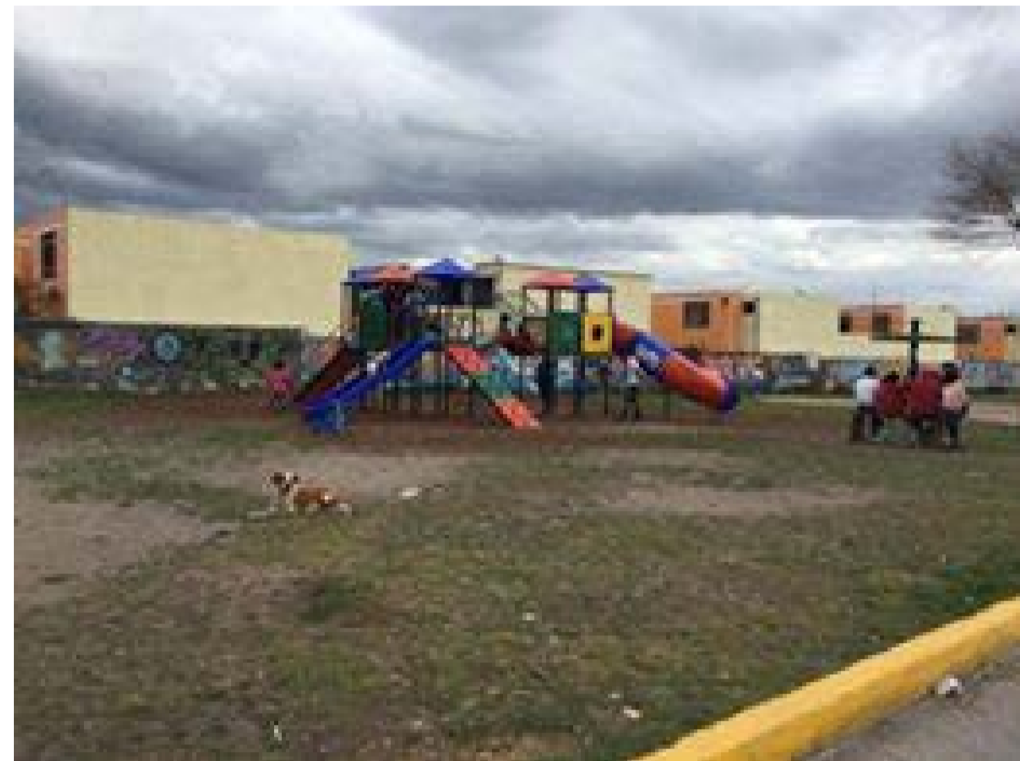
Zona infantil en deterioro
