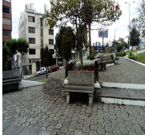
Fotografía 52. Barrera Urbana: Gradas al interior de la plaza (Plaza República del Perú TRAMO 1)
