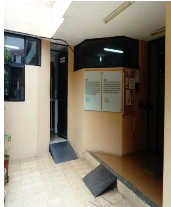
Fotografía 75. Rampa adherida interna en el Ballet Nacional de Ecuador (Calle José Abascal TRAMO 1)
