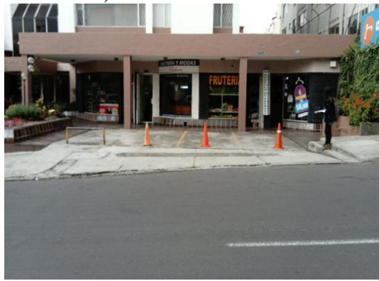
Fotografía 44. Barrera Urbana: Gradas sobre vereda (Av. Gaspar de Villarroel TRAMO 3)
