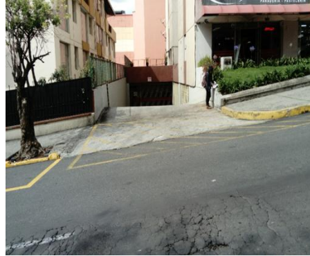
Fotografía 42. Barrera Urbana: Rampas de ingreso vehicular a edificios habitacionales. (Av. Gaspar de Villarroel TRAMO 2)
