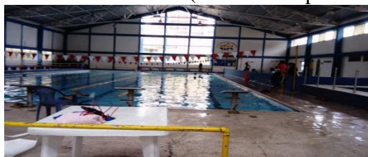
Fotografía 67. Pisos sin diferencia de texturas y señalética de la Asociación de Natación Pichincha. (Calle Cochapata TRAMO 2)
