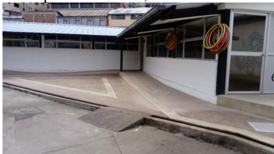
Fotografía 57. Rampas interiores en el CIBV-San Francisco de Quito. (Calle Cochapata TRAMO 2)
