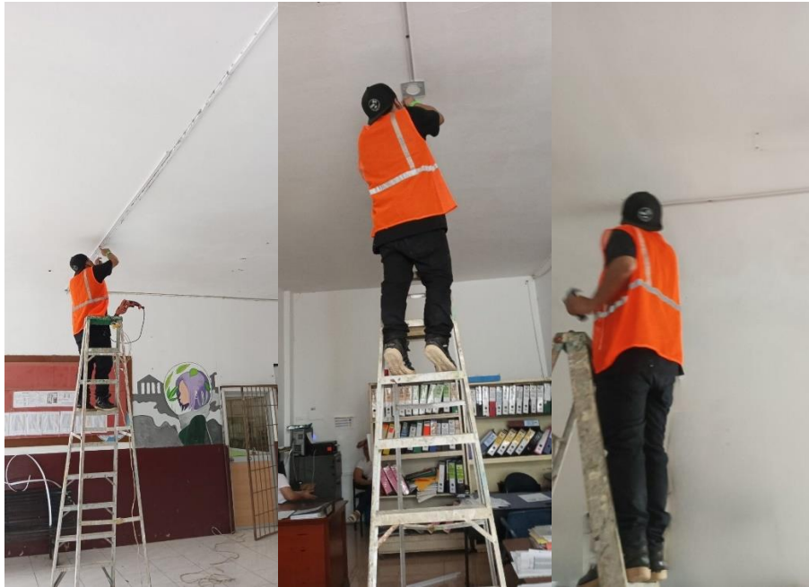
Figura 62 Instalación de canaletas Autor: Méndez Klevers
