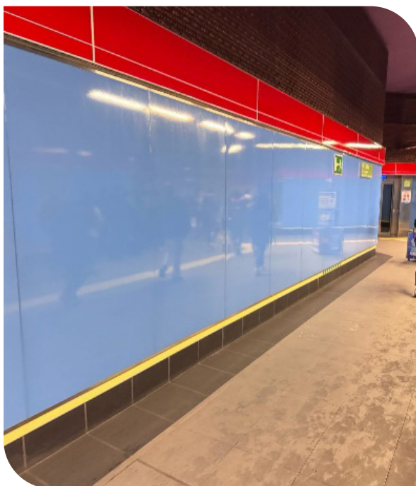
Figura 32 Fotografía del espacio del Metro
