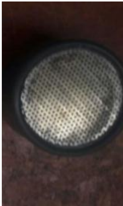
Figura 5: Regadera de baño
