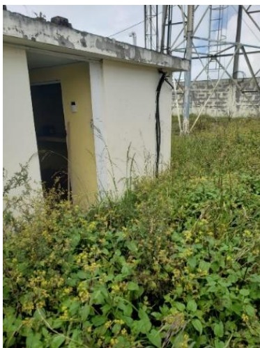
Vegetación al ingreso de cuarto de equipos
