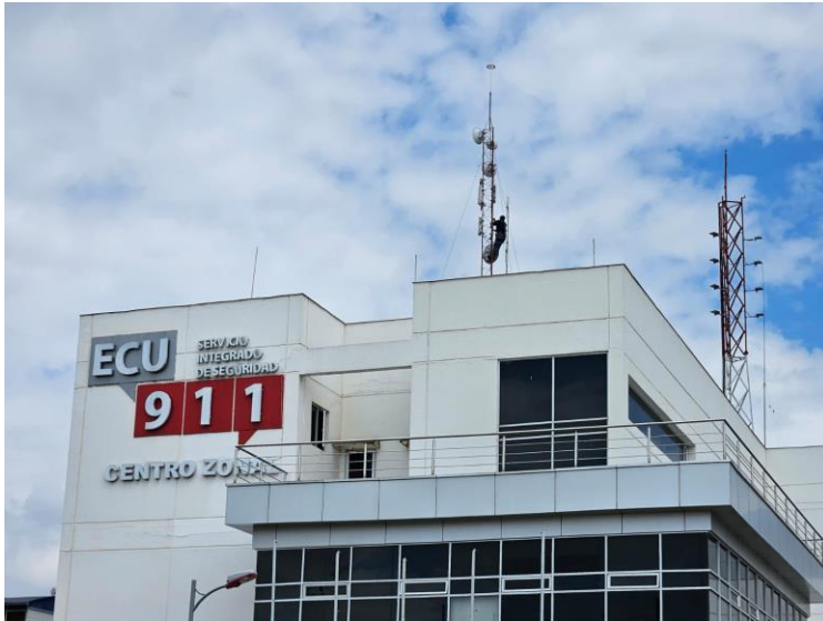
Figura 48. Edificio del SIS ECU 911
