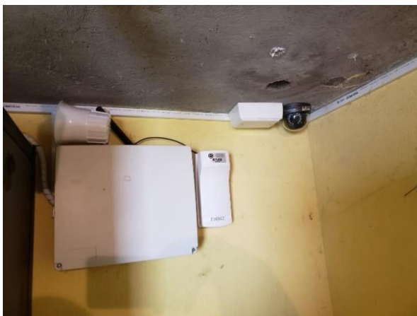
Figura 13. El sistema de alarma y sistema CCTV.
