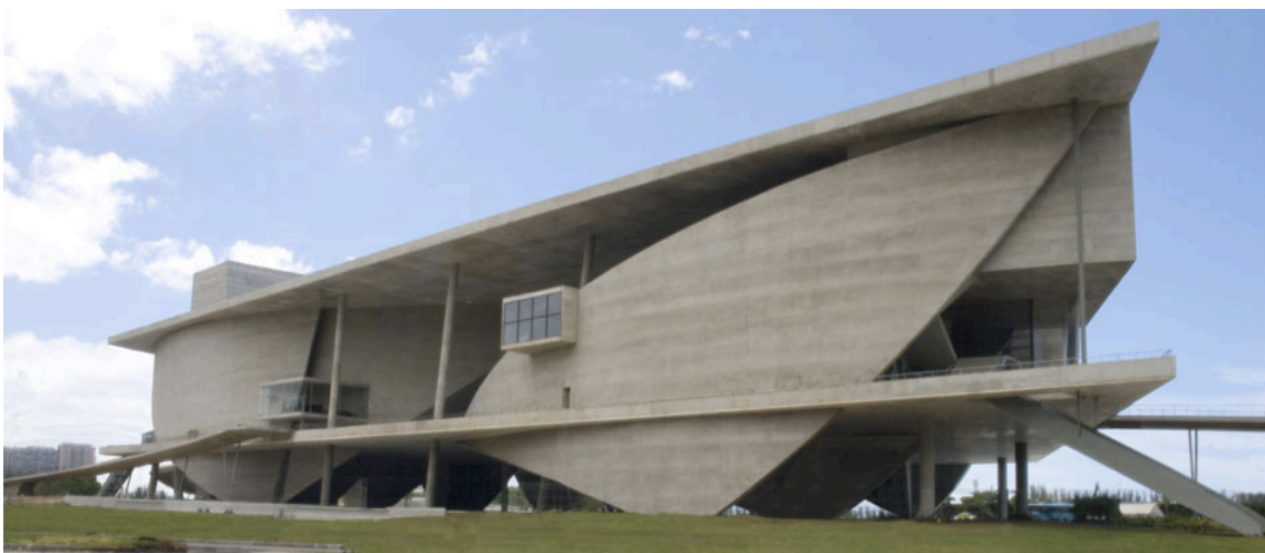
Exteriores de la obra en construcción
