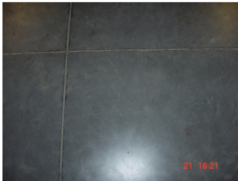
Ilustración 6.10: Parqueaderos sin fisuras, Supercines Quito Fuente: Miguel Rivera y José Sosa
