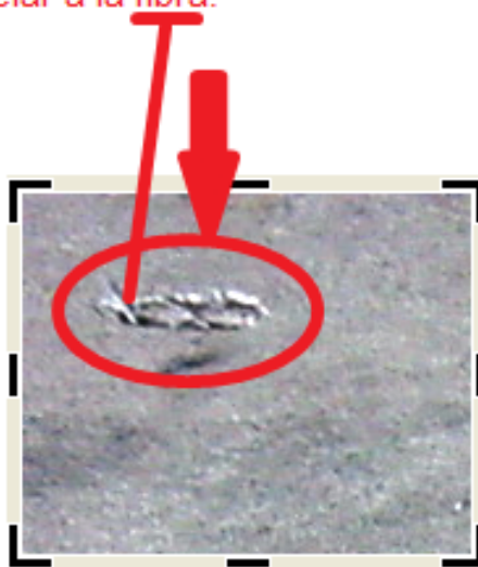
Ilustración 6.7: Bache en el que se puede identificar a la fibra Fuente: Miguel Rivera y José Sosa
