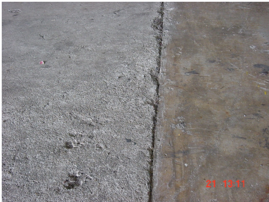
Ilustración 6.3: Desgaste de las rampas y parqueaderos del Condado Shopping Fuente: Miguel Rivera y José Sosa
