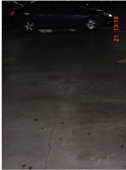
Ilustración 7.15: Identificación en las losas de entrapiso, Supercines Fuente: Miguel Rivera y José Sosa
