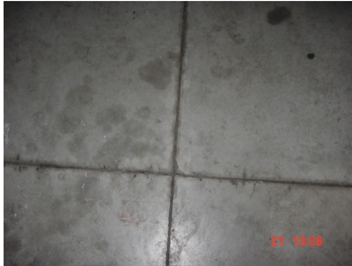
Ilustración 6.6: Parquaderos de hormigón con fibra RXF54 Fuente: Miguel Rivera y José Sosa
