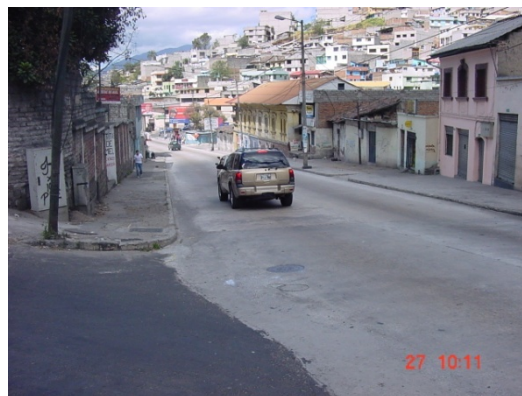
Ilustración 6.13: Pavimento rígido del Tramo 1, que va desde el redondel de Miraflores hasta la Av. Rodrigo de Chávez Fuente: Miguel Rivera y José Sosa
