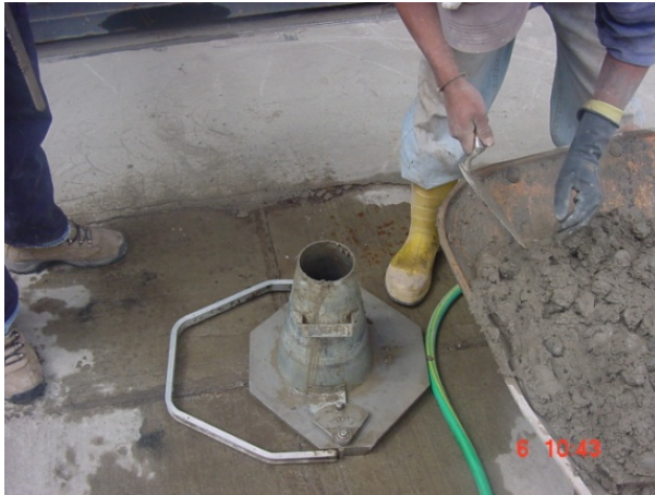
Ilustración 3.1: Preparación para obtener un asentamiento Fuente: Ensayos de Laboratorio para la investigación PUCE
