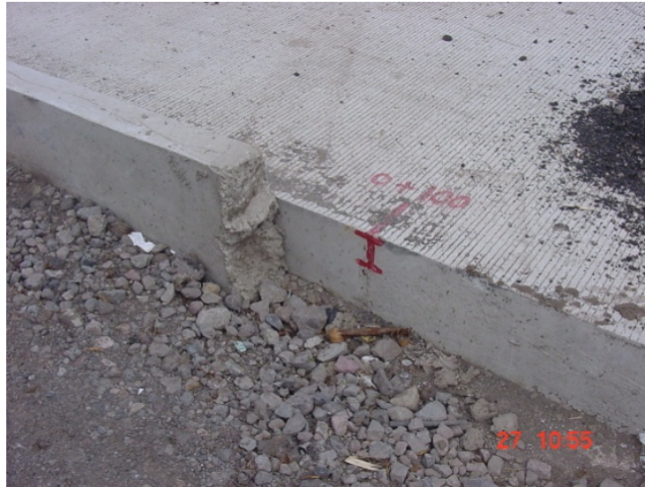
Ilustración 6.19: Detalle de la estructura de un Pavimento rígido, Sector Quitumbe Fuente: Miguel Rivera y José Sosa
