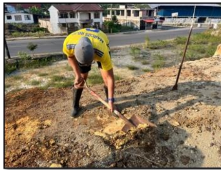
Figura 4. Excavación manual in situ
