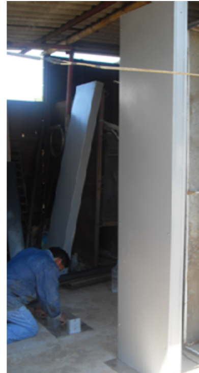
FOTOS DEL PROCESO DE PROTOTIPOS AEROPUERTO Fuente: Ziette Diseño (2013). Archivo de Registro de proceso de trabajo. [Fotografía].
