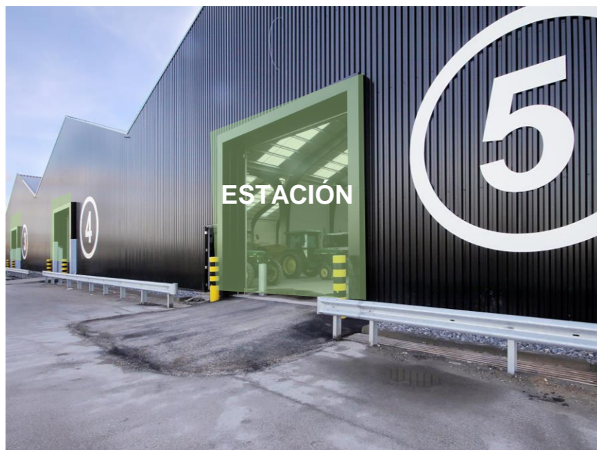
Figura 29: Fachada y su materialidad. Centro de reciclaje de Milieustraat / Groosman
