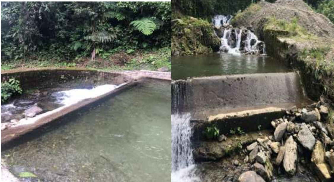
Figura 24. Formación de Sedimento Aguas Arriba y Aguas Abajo de la Estructura
