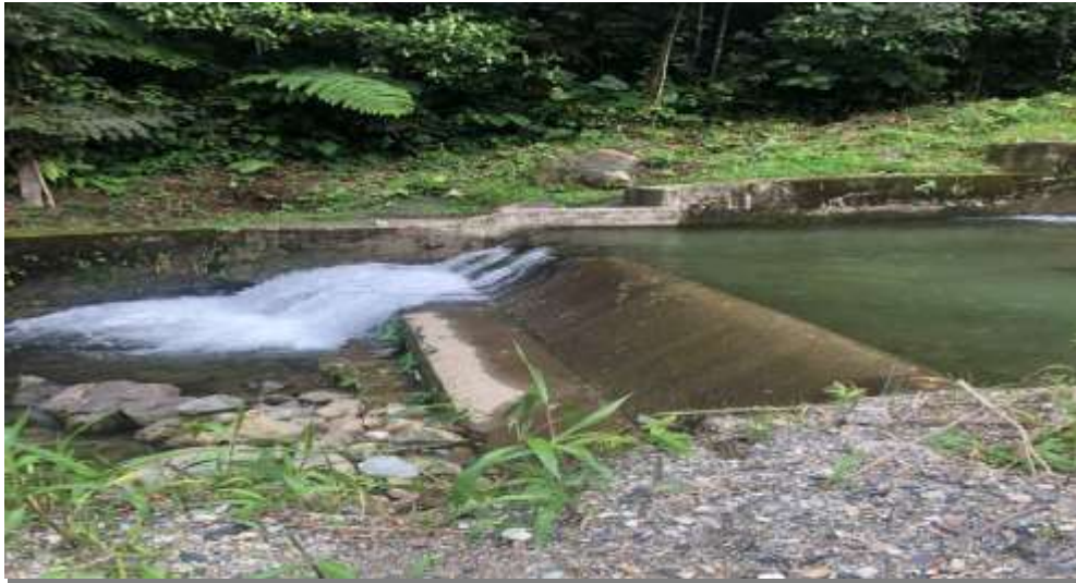
Figura 23. Azud de Derivación con Caída Libre
