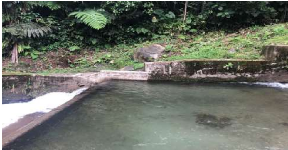
Figura 22. Muros de Ala de Ingreso
