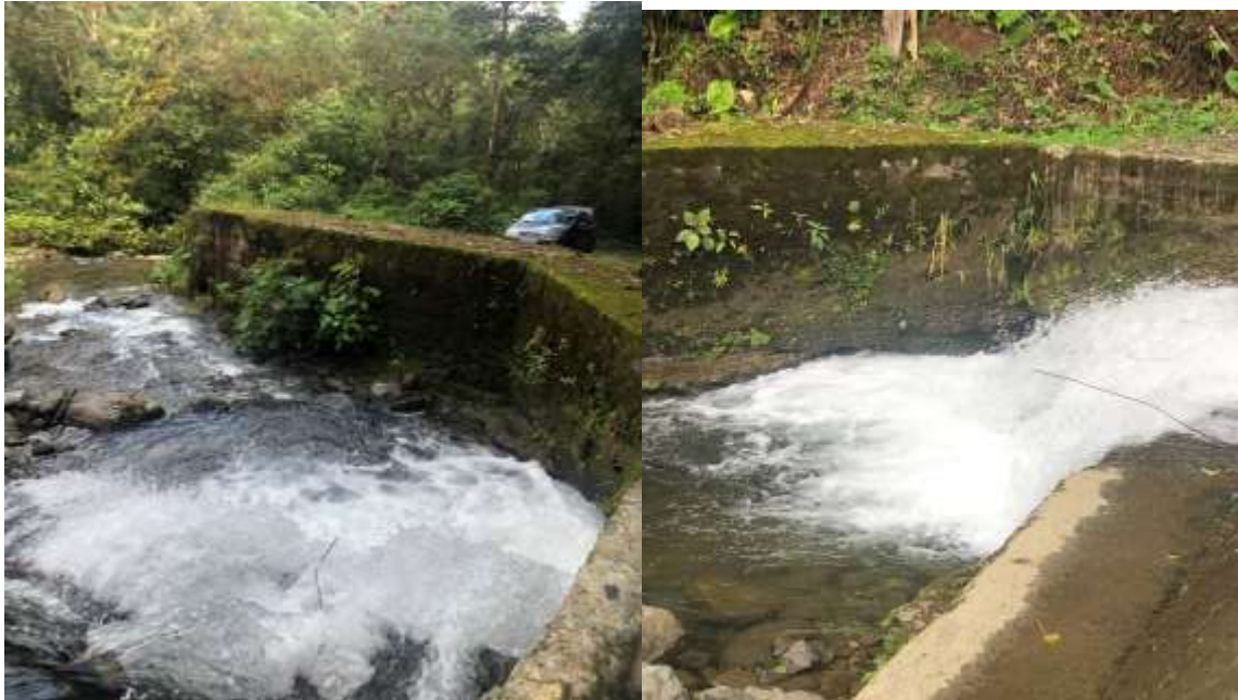
Figura 27. Muros de Ala de Salida
