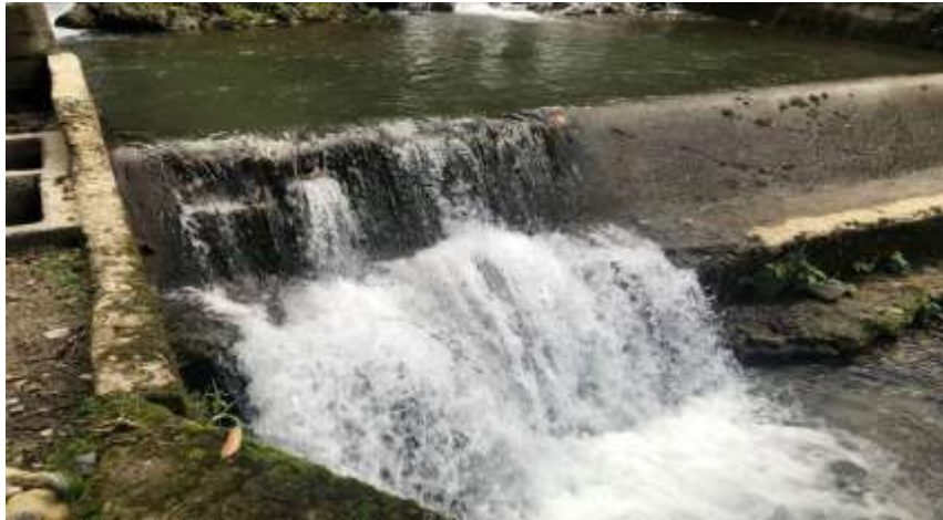
Figura 16. Obra de Toma
