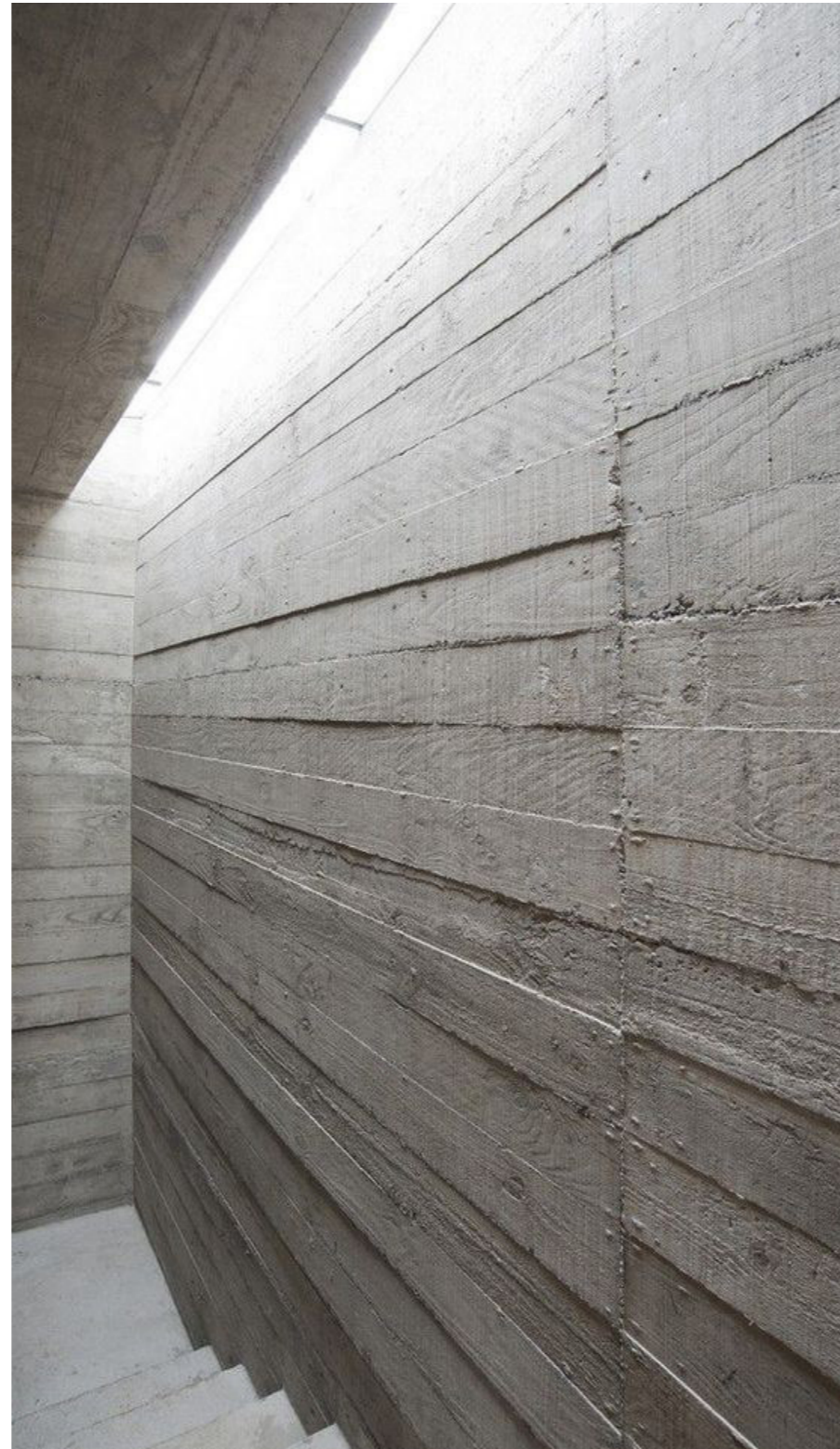
Ilustración 172. Textura de hormigón visto.
