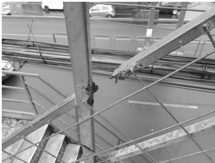
Figura 16. Estado actual puente peatonal.
