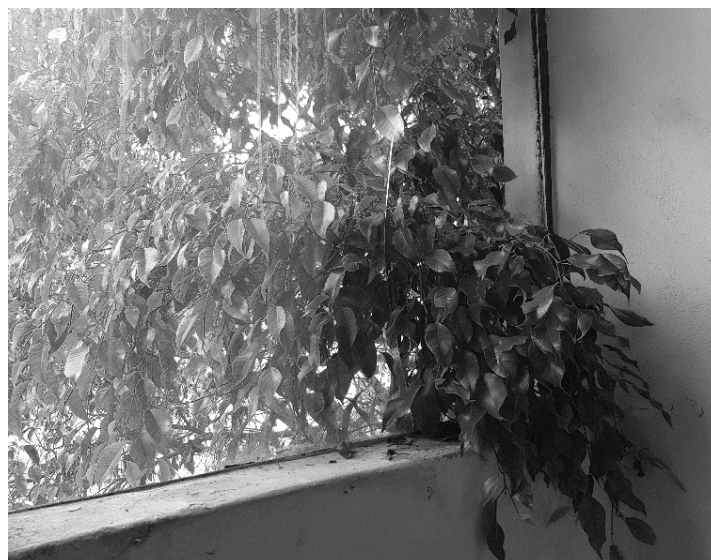
Figura 11. Vegetación que se introduce en el auditorio actualmente.
