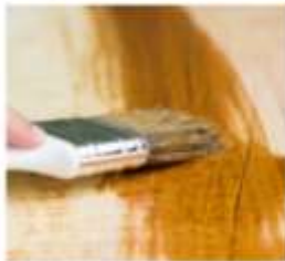
5. Se cubre la superficie con laca de piso.
