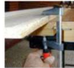
6. Una vez colocada la cola se procede a sujetarla con sargentos y esperar a que la madera seque.
