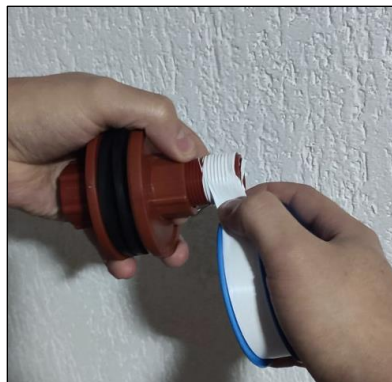
Ilustración 69. - Instalación adaptador para tanque
