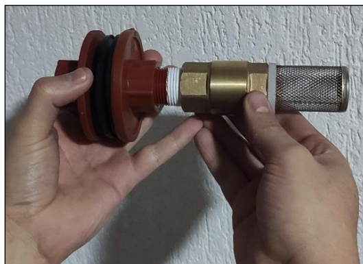
Ilustración 71. - Instalación válvula check con rejilla en adaptador de tanque
