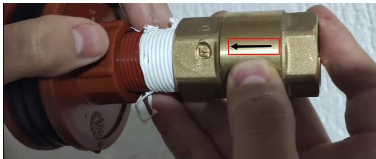
Ilustración 70. - Instalación válvula check con rejilla
