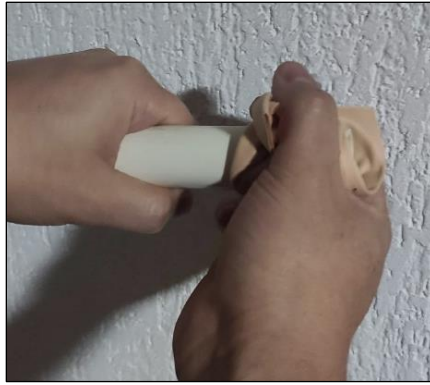
Ilustración 75. -Limpieza de tubería de PVC pegable
