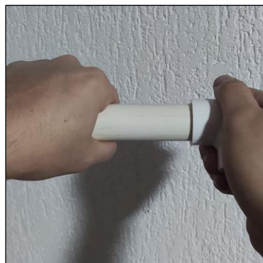
Ilustración 77. - Unión de tubería de PVC pegable
