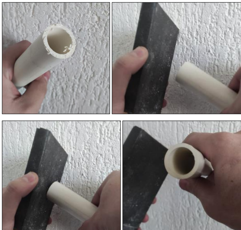
Ilustración 74. - Preparación tubería de PVC pegable
