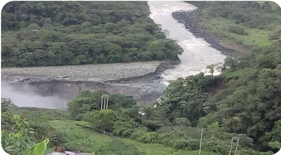
Construcción de variantes km 95+700 y 96+500, por fenómeno de Erosión regresiva del río alto coca.
