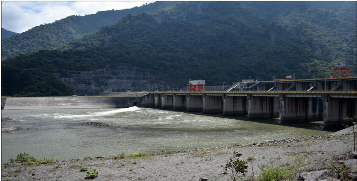
Las obras de captación de Coca Codo Sinclair que se quiere proteger de la erosión. El fenómeno erosivo se encuentra a 8 kilómetros de la captación.
