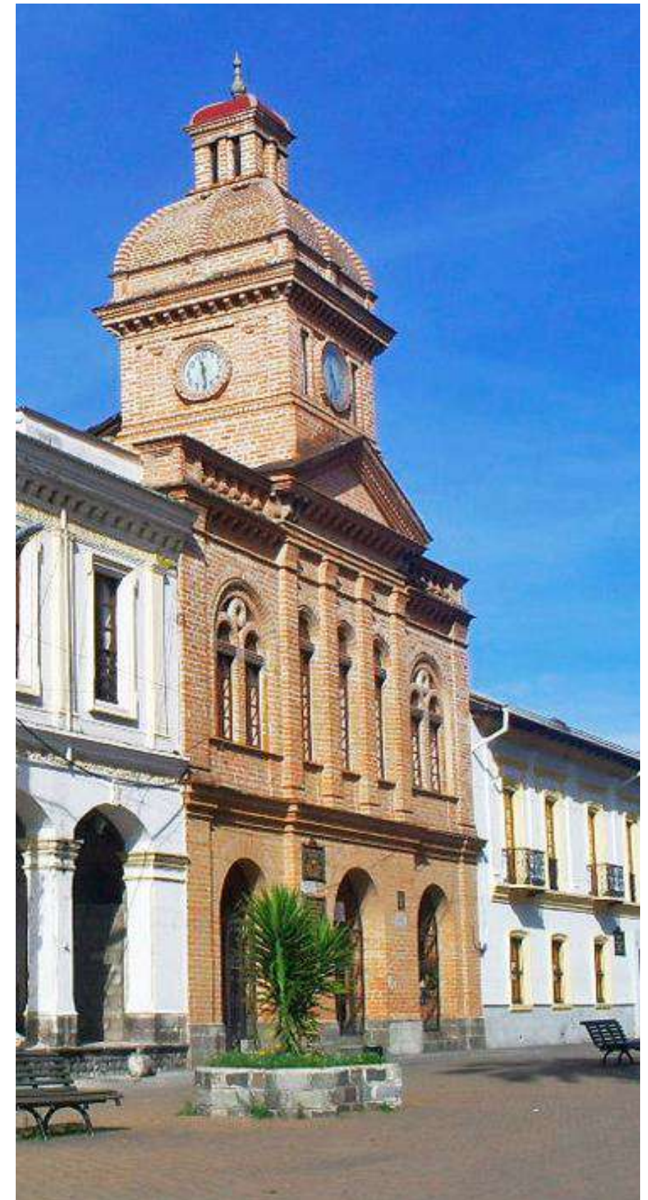
Figura 9: Torreón del Colegio Teodoro Gómez. Fuente: Arias, 2017.
