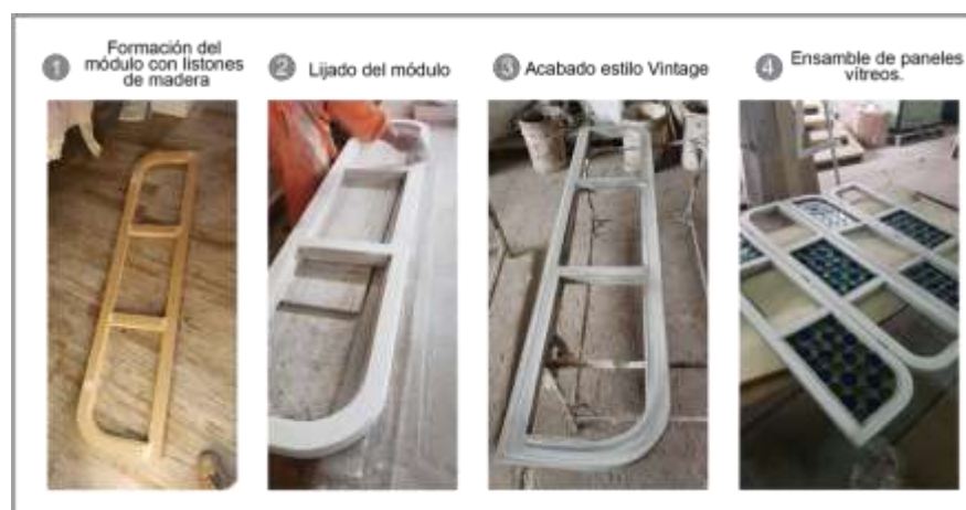
Imagen 2.58. Proceso Estructura de Madera.
