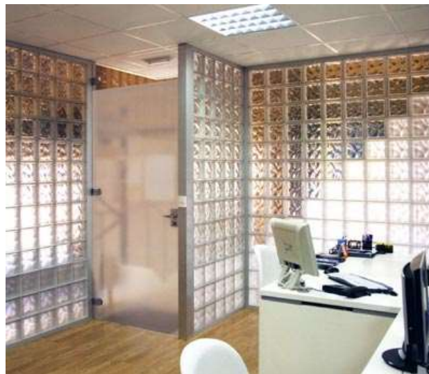
Imagen 1.25. Paredes de pavés o paredes de vidrio.
