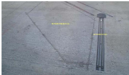
Sensores piezos para conteo de ejes y detección doble rodada
