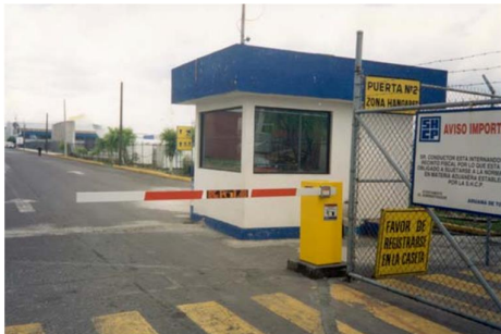
Barrera situada en el control de acceso a zona aeroportuaria
