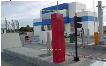
Detalle de expedidor de tickets, semáforo, cámaras CCTV
