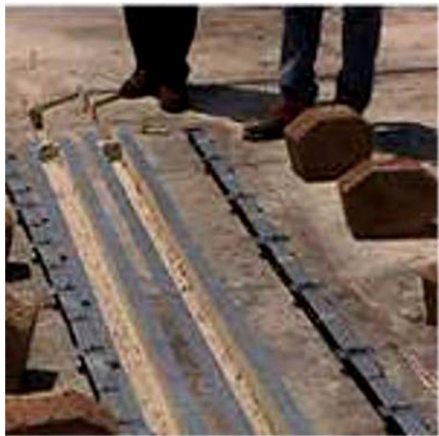
Cajas para sensores piezoeléctricos tipo reemplazable
