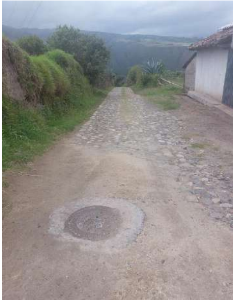
Ilustración 8 Levantamiento de información en campo. Sector del paramo
