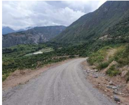
Ilustración 15 Proceso de lastrado de la vía
