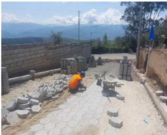
Ilustración 22 Vía en construcción de adoquinado
