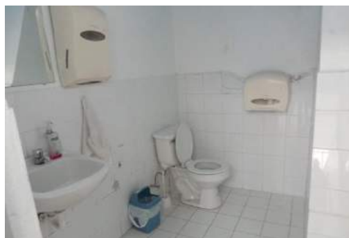
Batería sanitaria dentro del área de rehabilitación
