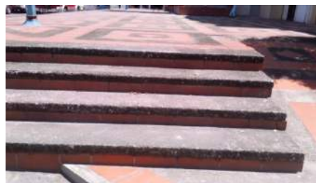
Escaleras al ingreso de Iglesia
