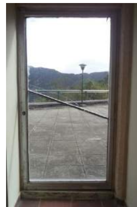
Puerta al mirador de la segunda planta
