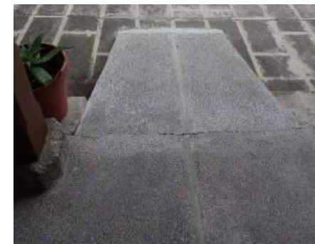
Rampa diseñada para acceder al centro del convento
