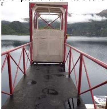
Pasamano al ingreso del ascensor
