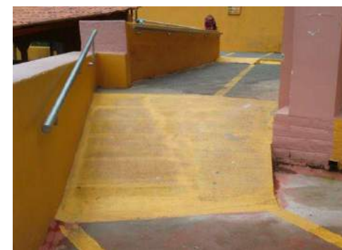
Rampa de acceso al segundo piso del ascensor
