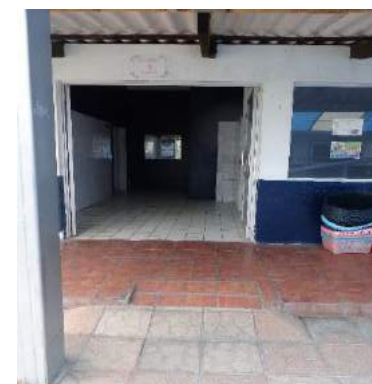
Rampa de ingreso al vestíbulo
