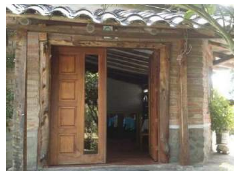
Puerta de ingreso al comedor
