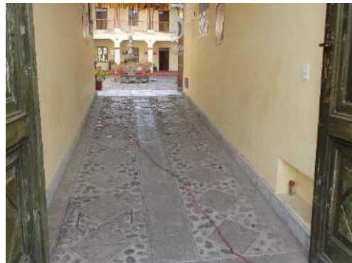
Primera rampa de ingreso al museo
