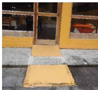
Rampa de acceso entre comedor y cabañas
