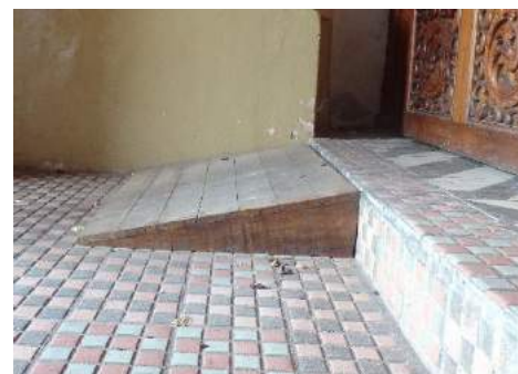
Rampa interna de acceso a la Catedral
