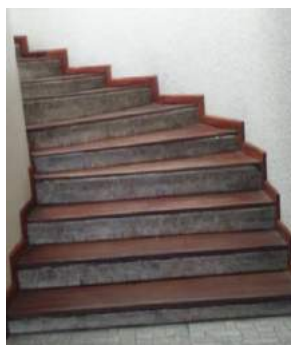
Escaleras de ascenso a tercera planta de la hostería.
