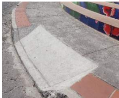
Rampa externa calle Bolívar
