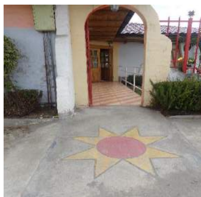
Rampa de ingreso al centro
