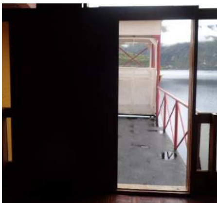
Puerta de acceso al ascensor en la tercera planta
