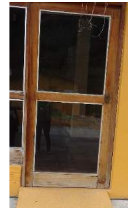
Puerta de acceso al comedor
