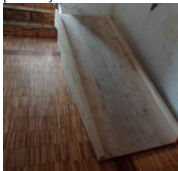
Rampa usada para salvar el ingreso a la cafetería convento
