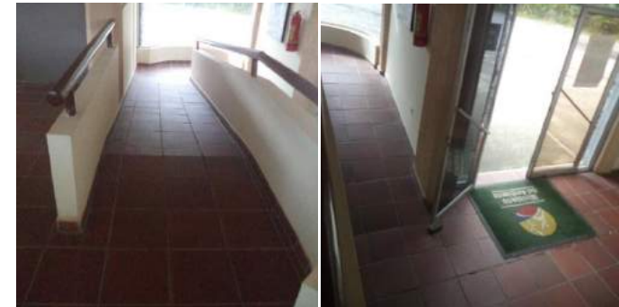
Rampa acceso de segunda a tercera planta
