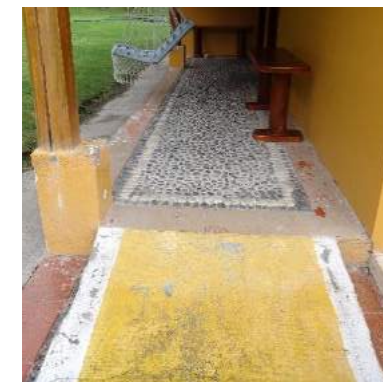
Rampa de acceso a las cabañas
