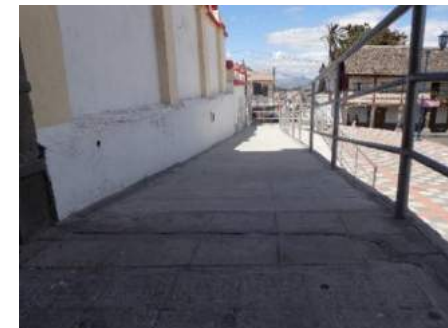
Rampa externa que salva de desnivel de gradas
