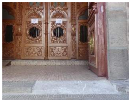
Rampa externa de ingreso
