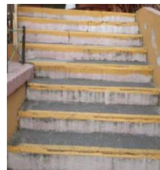
Escalera de ingreso al segundo piso de la hostería
