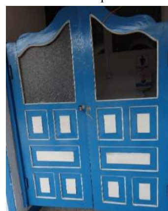
Puertas de ingreso a baterías sanitarias
