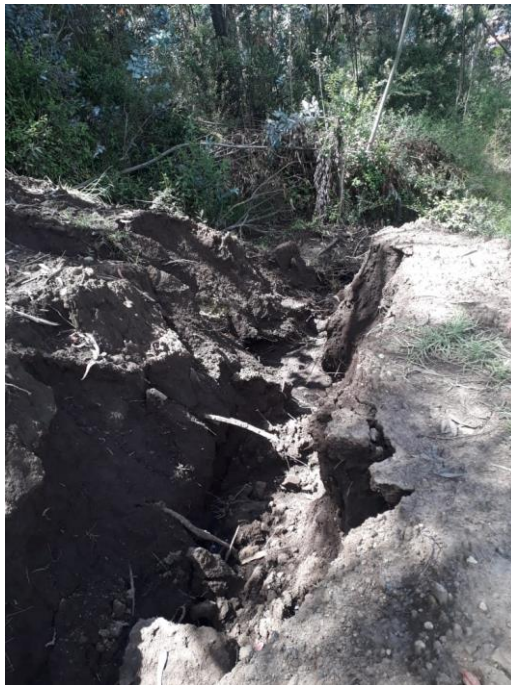
Imagen 1: Erosión en el barrio Protección Chillogallo
