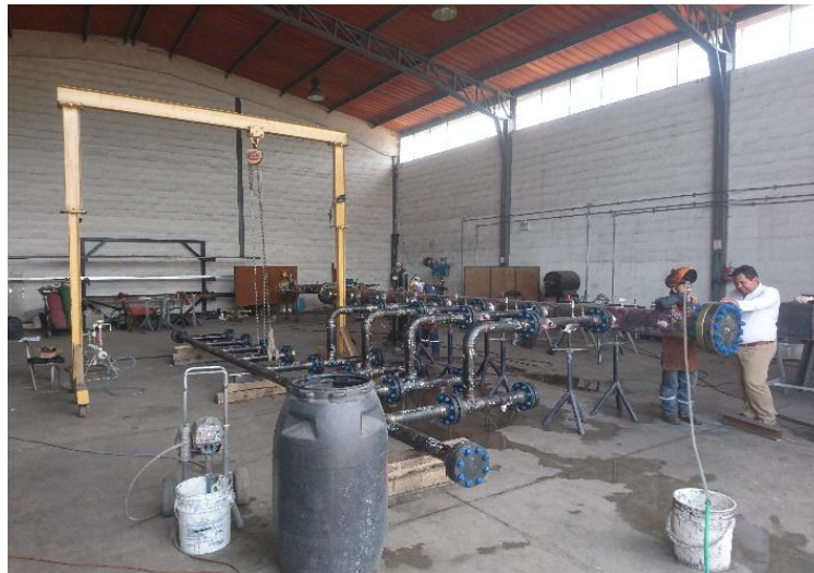
Figura 14. Área de trabajo de Piping.
