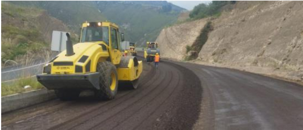
Ilustración 31 Compactación de Suelo Estabilizado
