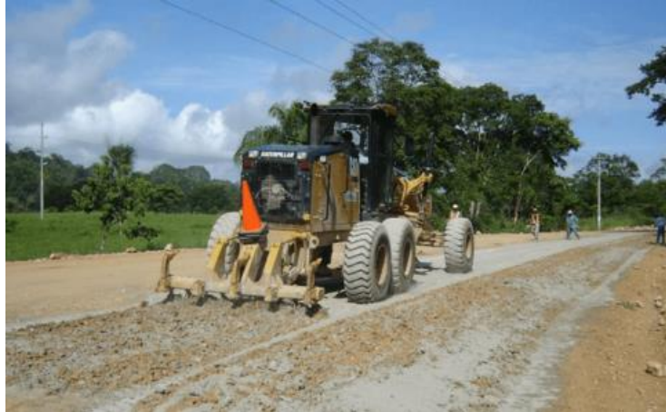
Ilustración 2 Estabilización Química Utilizando Cemento
