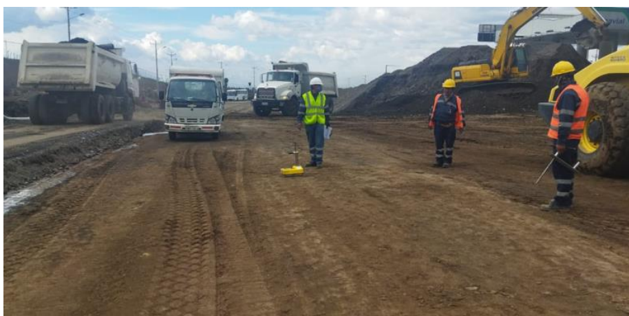
Ilustración 15 Control de Compactación
