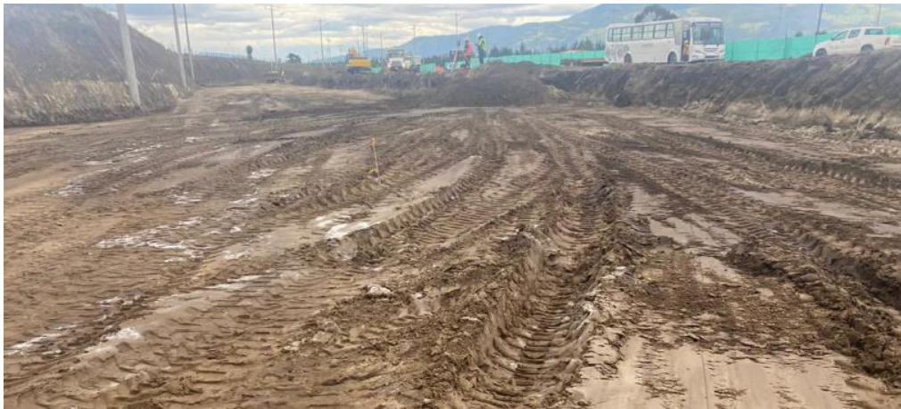
Ilustración 32 Baja Durabilidad de una Subrasante Natural
