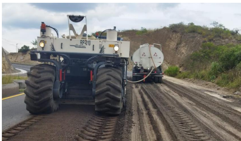
Ilustración 29 Estabilización de Suelos con Emulsión Asfáltica
