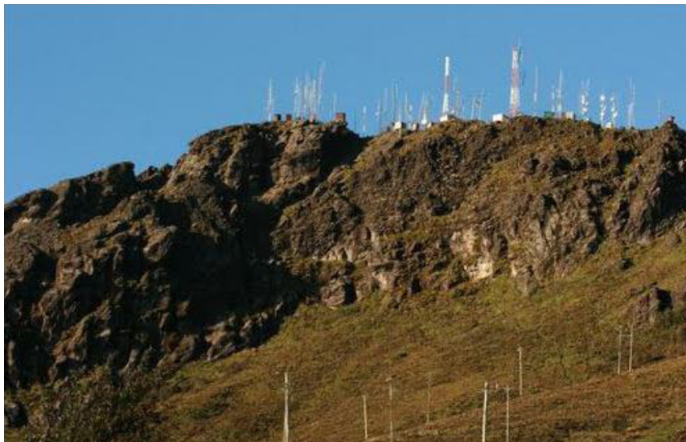
Figura 4.8. Torres de la repetidora del Atacazo
