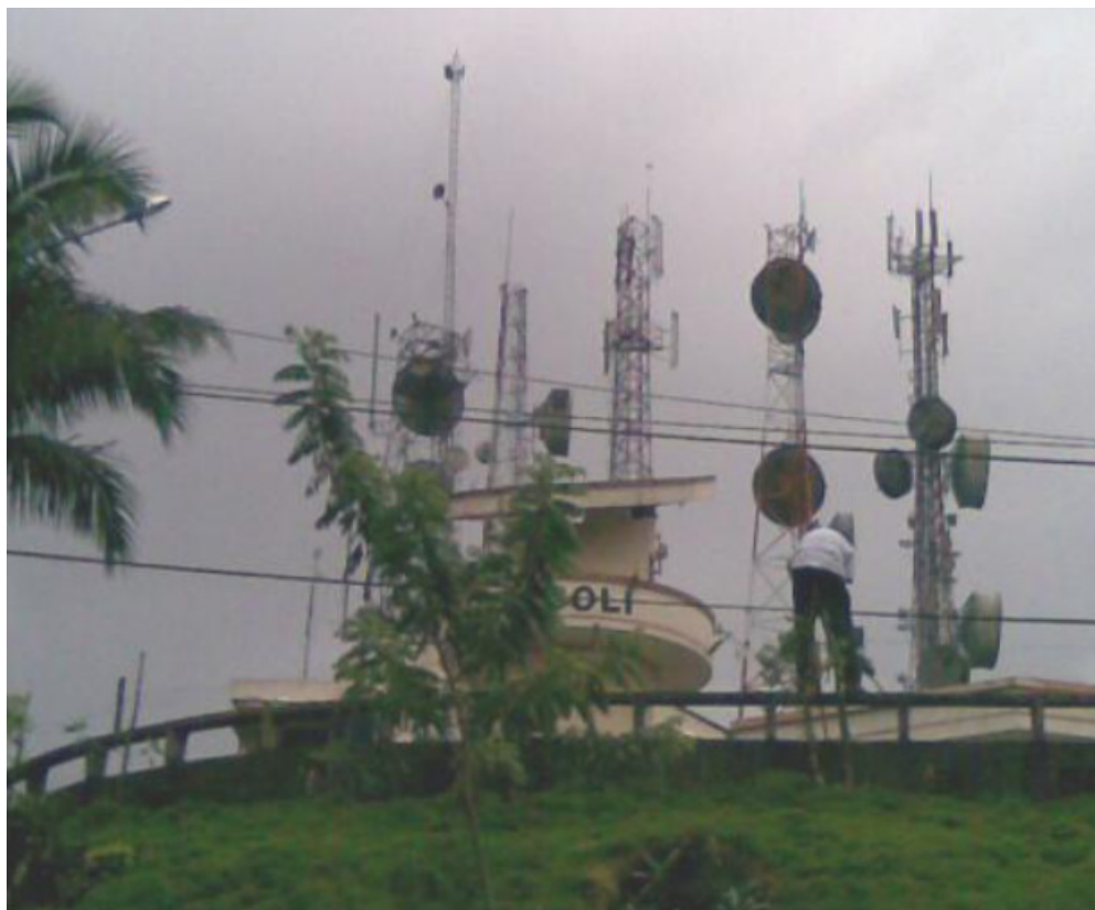
Figura 4.9. Torres de la repetidora del Bombolí
