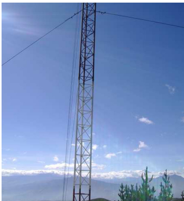
Figura 4.10. Torres de la repetidora de Guango
