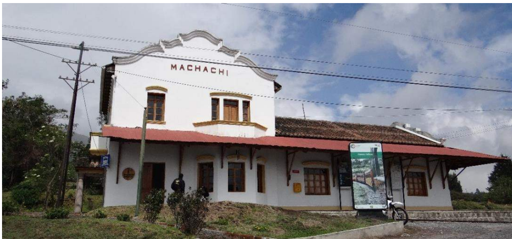
Estación del Ferrocarril Machachi.
