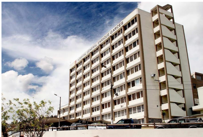
Fotografía 1: Fachada Hospital Enrique Garcés / Quito – Ecuador
