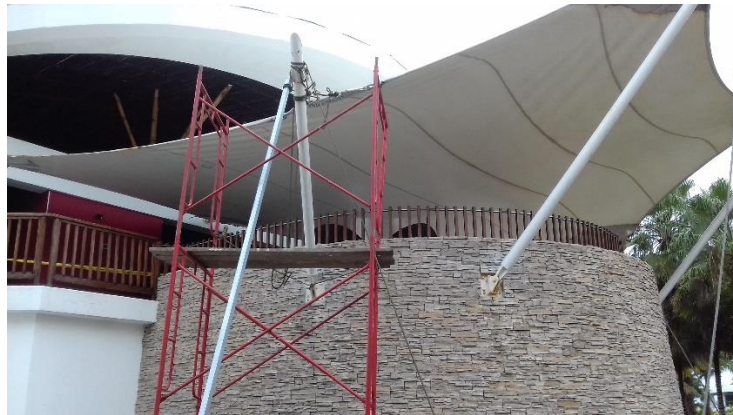
Fotografía 3: Reparación de tensomembranas por el área de mantenimiento
