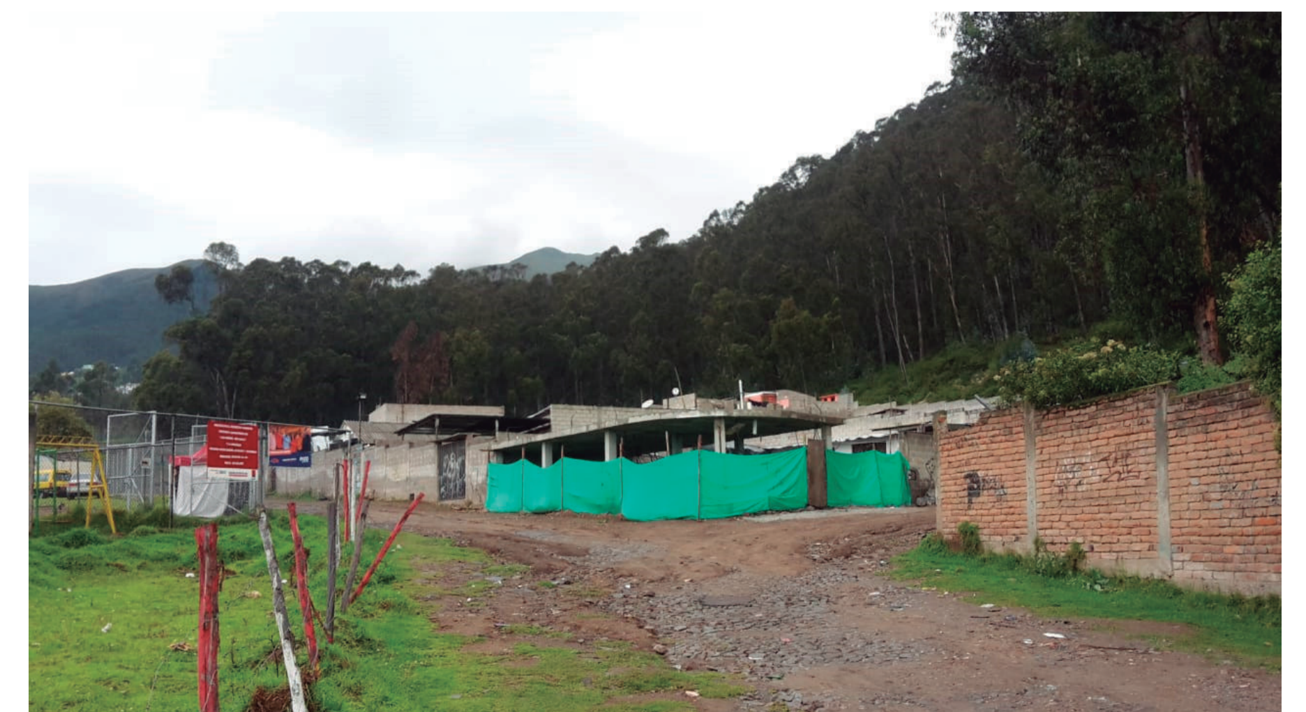
ASENTAMIENTO INFORMAL "LAS HIEDRAS", EXTERIOR
