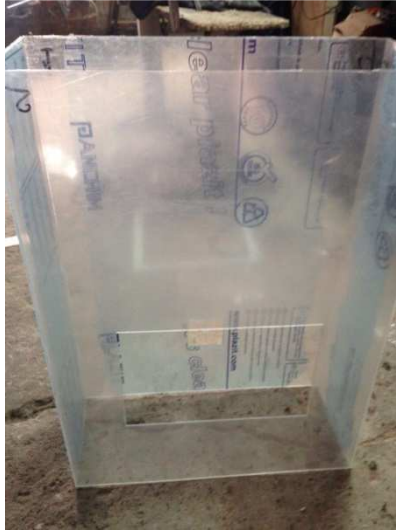
Figura 146. Construcción del Dispensador (1). Fuente: El Autor.
