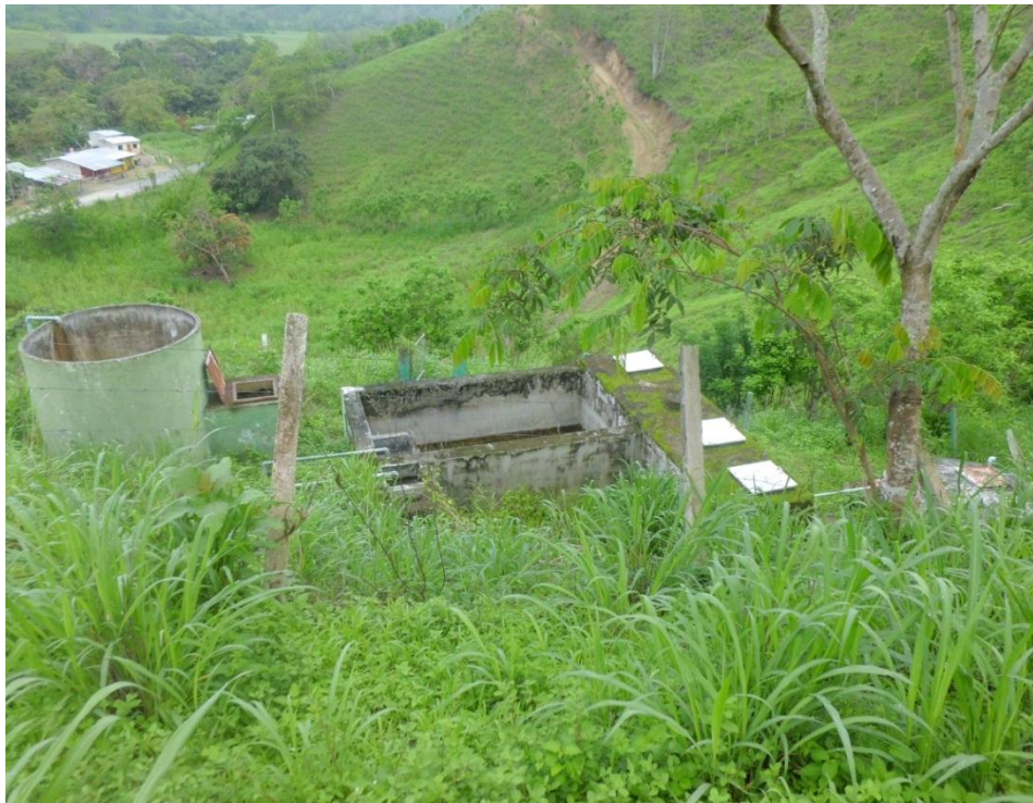
Fotografía 1.1 Sistema de Almacenamiento y Desinfección Actual (sin funcionar)
