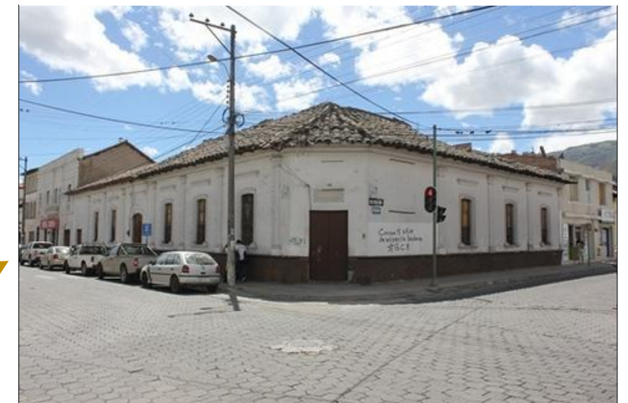
Figura. 68 Fotografías esquineras del lote elegido.
