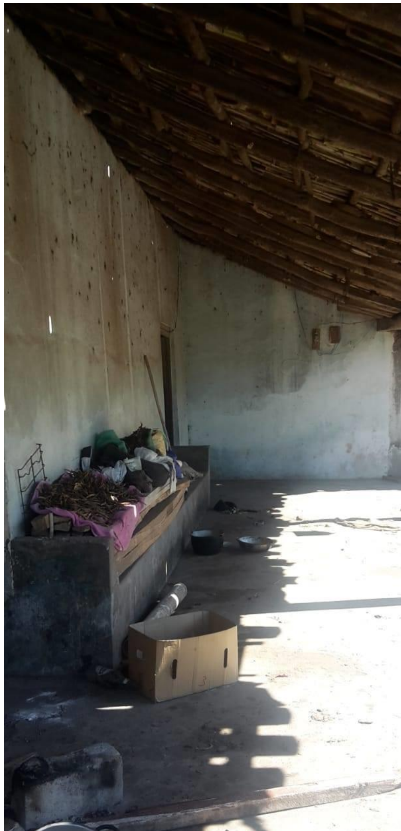
Imagen 42: Corredor de la vivienda tradicional Fuente: Joseline Moreta Torres
