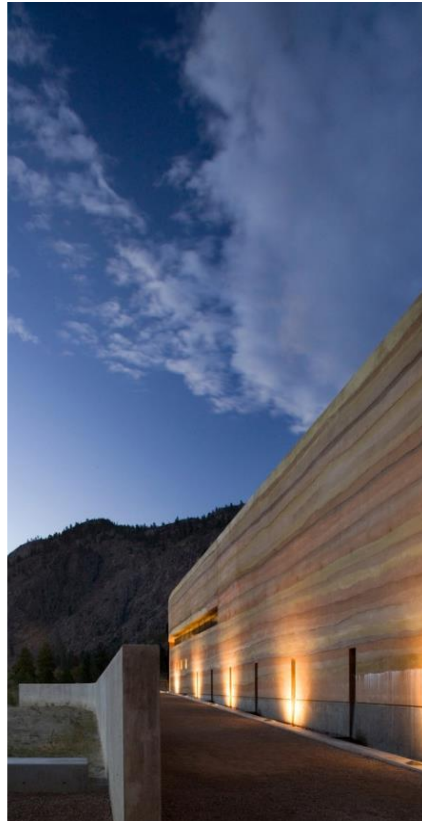
Imagen 83: Vista externa a la rampa de acceso a la terraza del Centro Cultural Fuente: Nic Lehoux
