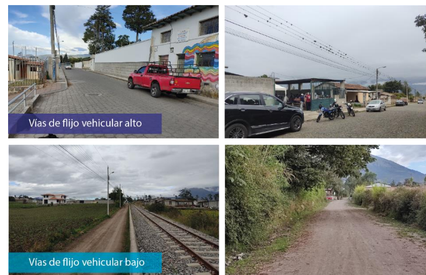
Imagen 147: Estado actual de las vías del polígono de estudio Fuente: Joseline Moreta Torres
