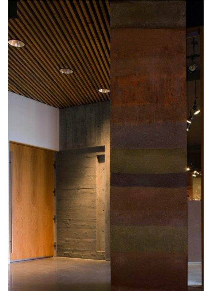
Imagen 91: Materiales locales empleados en la construcción del Centro Cultural Nk' Mip Fuente: Nic Lehoux
