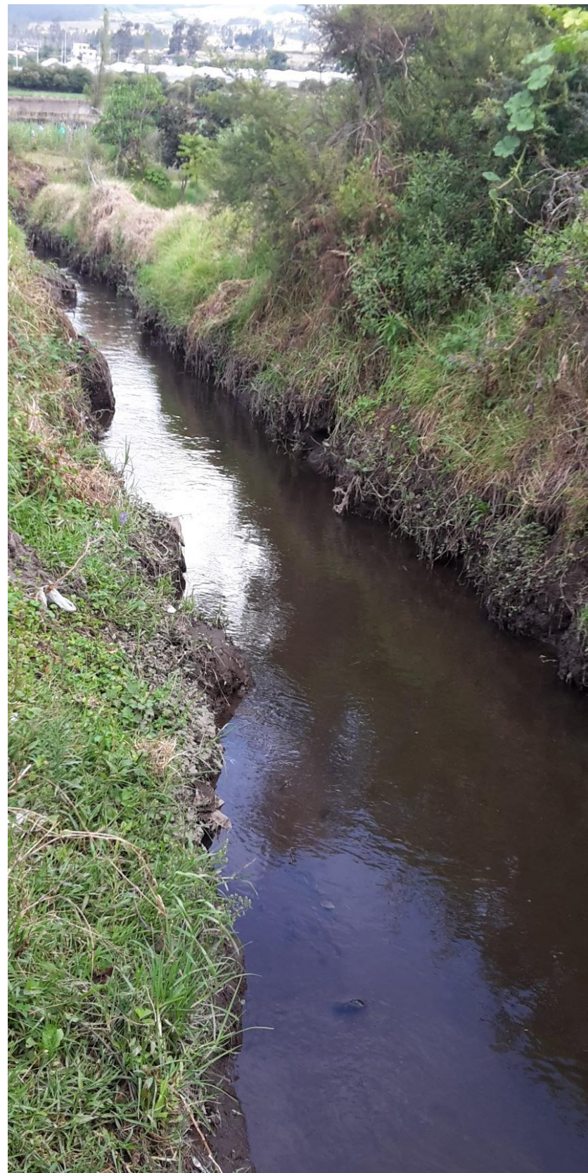
Imagen 204: Acequia Peguche, antes de ingresar a la caja repartidora de agua “El Óvalo” Fuente: Joseline Moreta Torres
