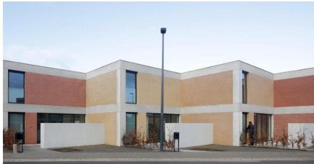
Figura 3. Vivienda de interés social ubicada en Alemania
