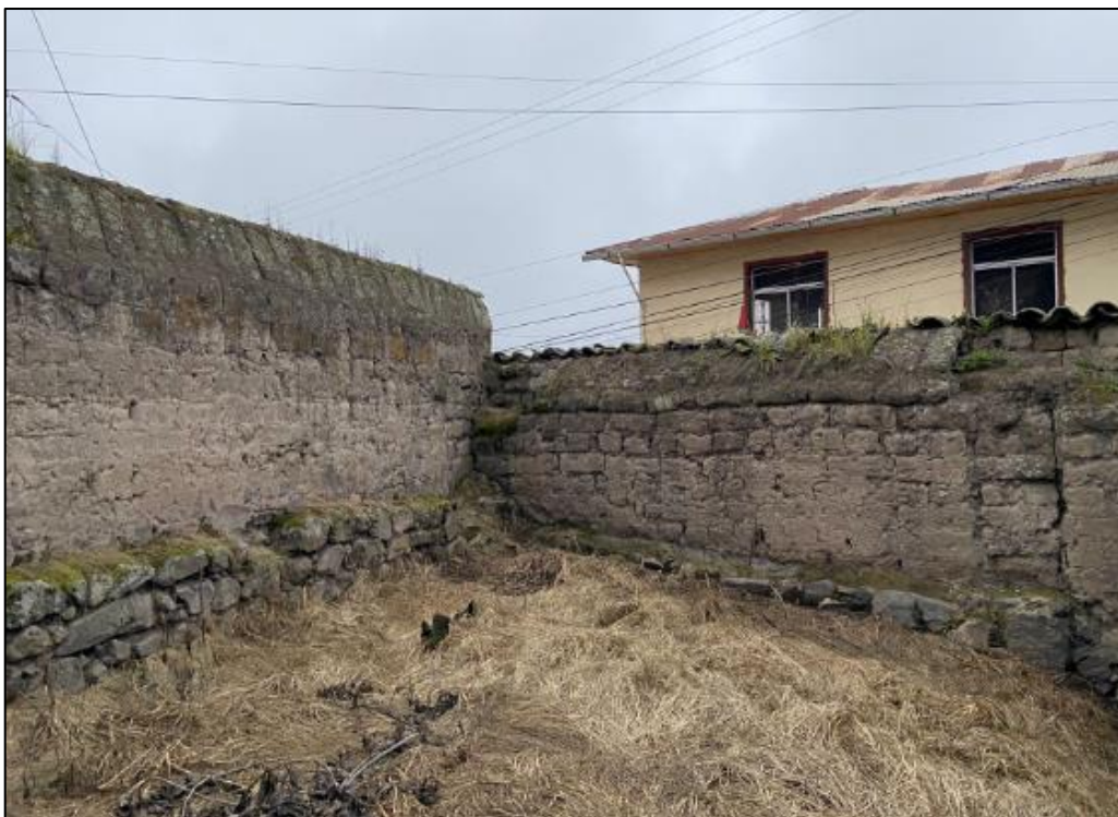
Ilustración 10: Viviendas con muros construidos con tapial – Elaboración Propia
