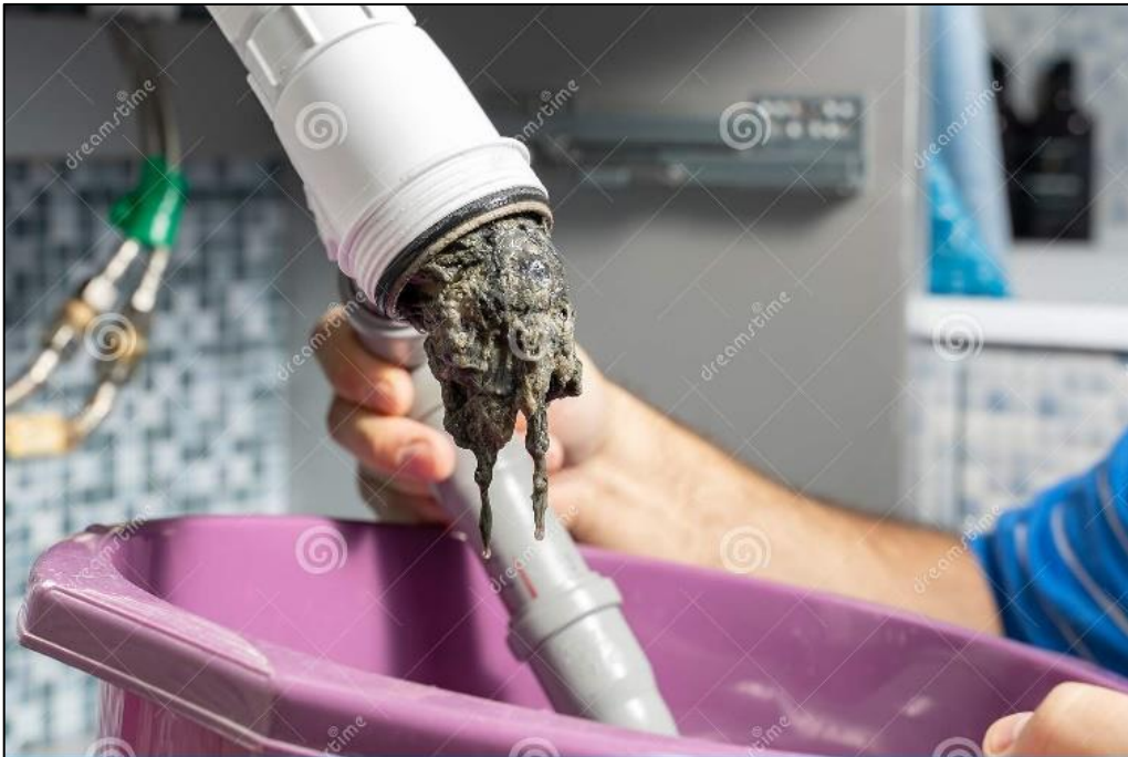
Ilustración 58: Bloqueo de tuberías - (Dreamstime, 2022)
