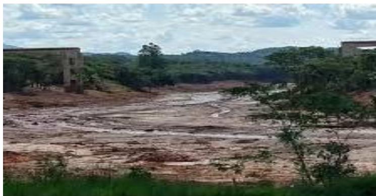
Figura 10. La Actualidad (Post-desastre y Reparación Inconclusa)
