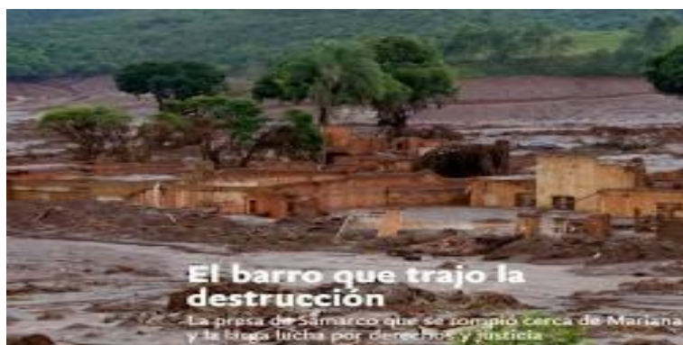
Figura 6. Durante: La avalancha de lodo de la represa de Samarco arrasando con la comunidad.
