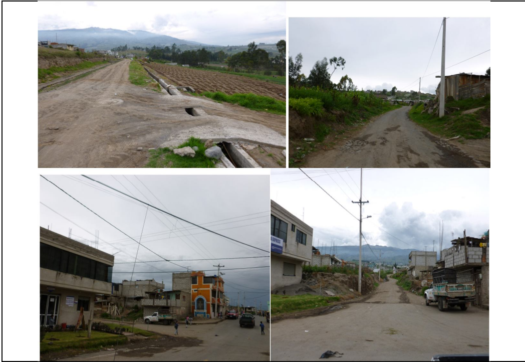
Fotografía N° 8: Estado vialidad Macasto Elaborado por: Arq. Patricia Mora, 2013
