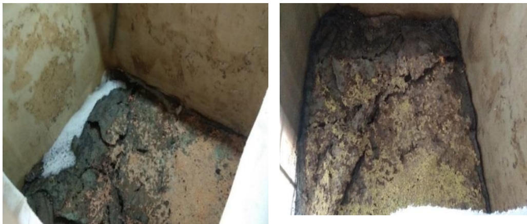
Figura 12. Tanque de almacenamiento de los lodos de los laboratorios de la ECAA.
