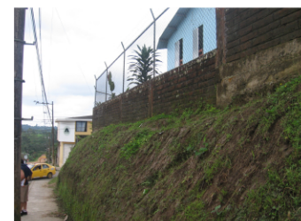
FACHADA LAT. IZQ. ESCUELA
