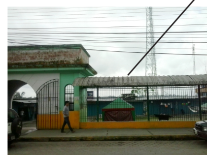
CUBIERTA EN LA FACH. FRONTAL
