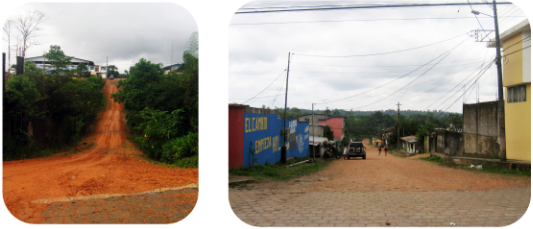
Vía Local lastrada
