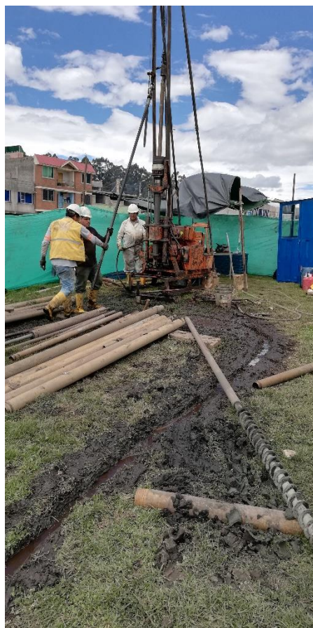
Fotografía 1 Sitio de perforación el Garrochal. Maquina Acker ACE
