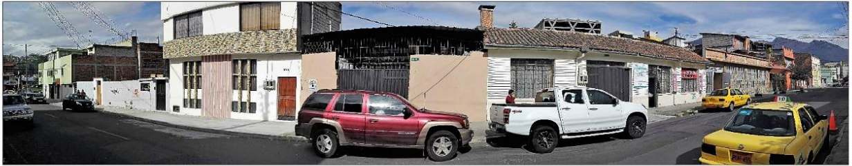
FACHADA EXISTENTE, CALLE LÉRIDA
