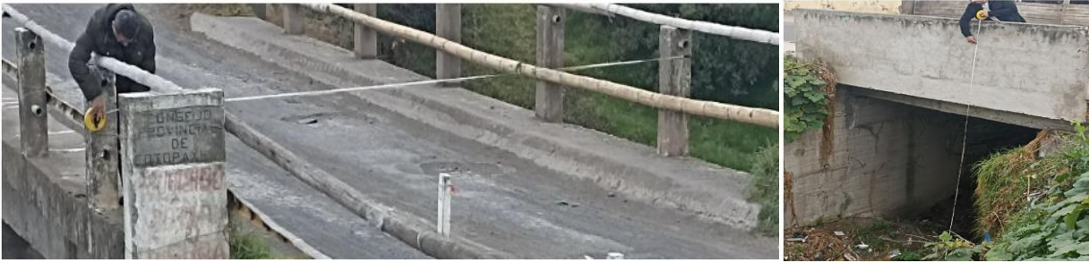
18. Medida de galibo y evaluación de protecciones, revisión de estado de estructura e infraestructura
