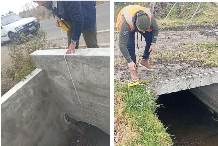
17. Levantamiento e inspección visual de alcantarillas.
