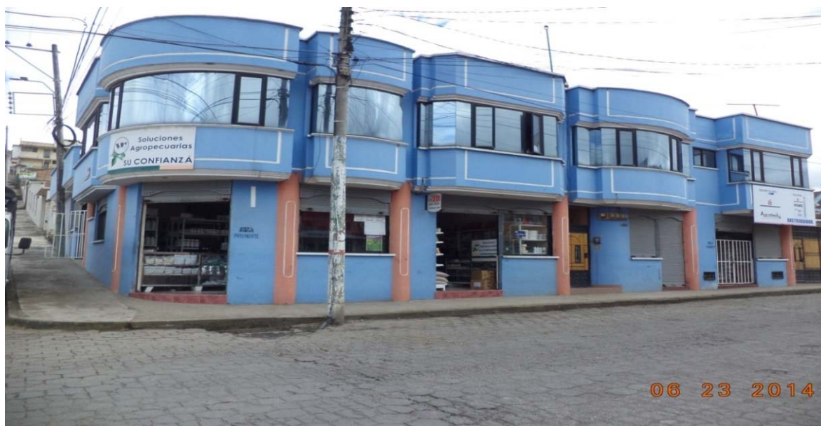
Figura 3: Fotografía de la fachada exterior.
