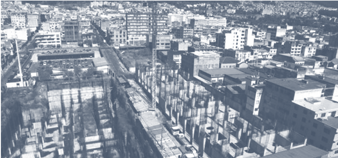
Figura 21. Edificios en desuso dentro del barrio Larrea . Elaboración propia
